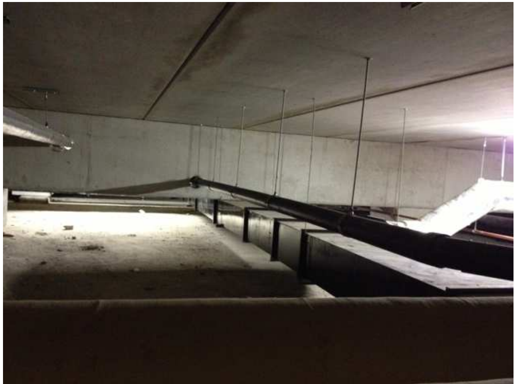
Foto 1: Kelder ter plaatse van het voormalige postkantoor
